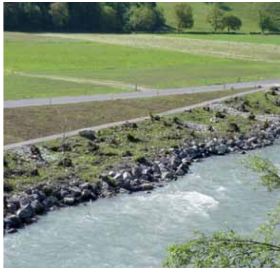
Hochwasserschutz und Renaturierung Lütschine, Bönigen
